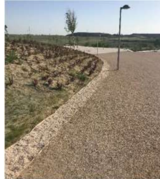
Franja d'infiltració a La Atayuela, Madrid
