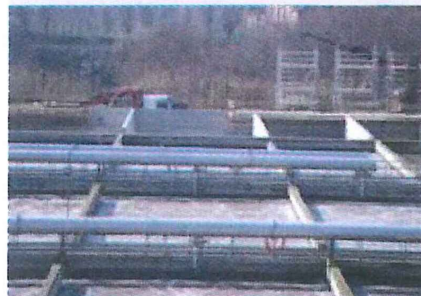
Ampliació reactor biològic
